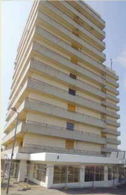
▲ Die letzten Mieter sind ausgezogen, die Ladenlokale sind geräumt.
