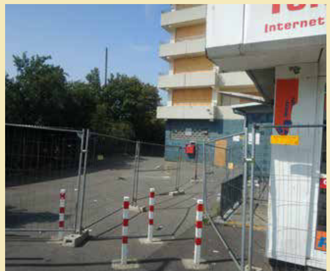
▲ Mit einem Zaun gesichert und überwacht wird das marode Hochhaus. Fotos: bb
