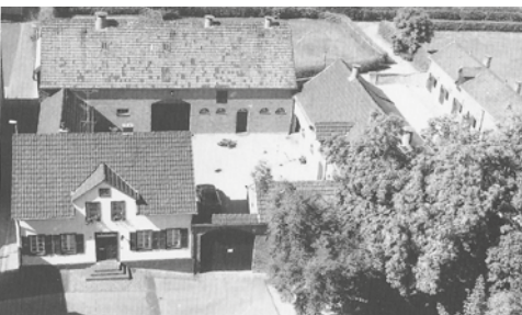
▲ Die alte Stallanlage des Gestüts Schlenderhan.
